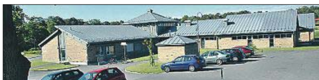
Stavern: Presteløkkka får mye ros for sitt rehabiliteringsarbeide. (Arkivfoto)
